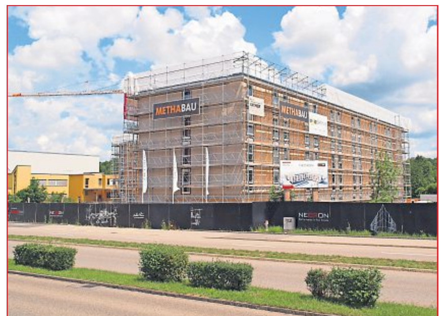
An der Flughafenstrasse ist der Rohbau des ersten Intercity Hotels der Schweiz abgeschlossen. Die Eröffnung dürfte Mitte 2021 zu erwarten sein.
